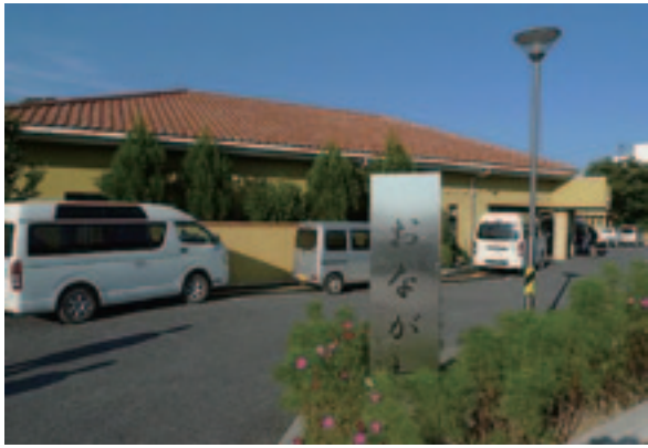
地震による躯体の被害はそれほど大きくない
