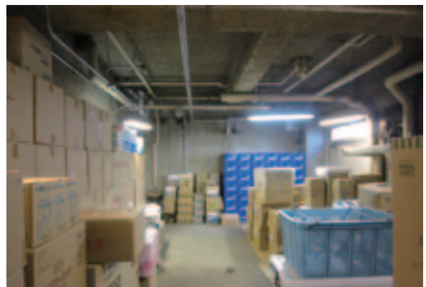
備蓄倉庫 元ボイラー室
