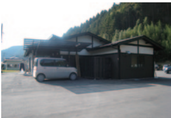
施設外観 手前が小規模多機能型居宅介護
