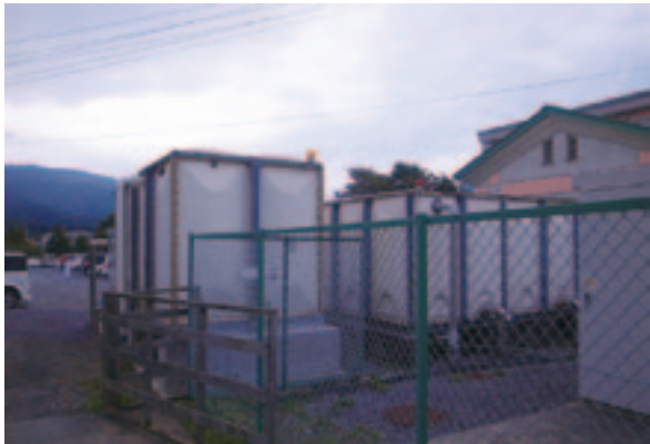
井水水槽（震災後設置）敷地全体（松原苑など）で共有
