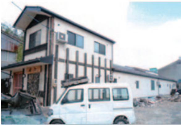
津波被害にあった施設（村伝）※
