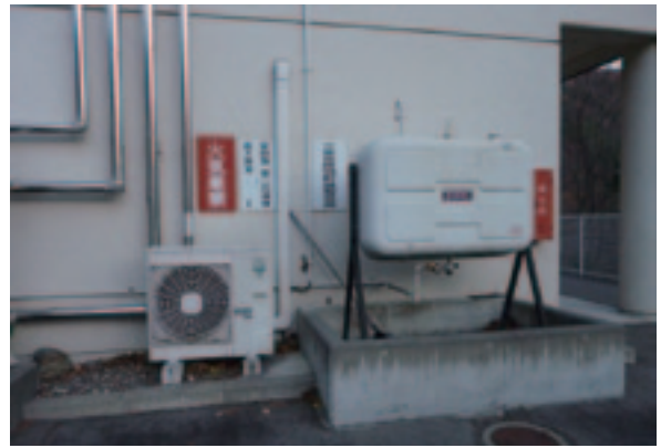
外部オイルタンク（設備に損傷なし）
