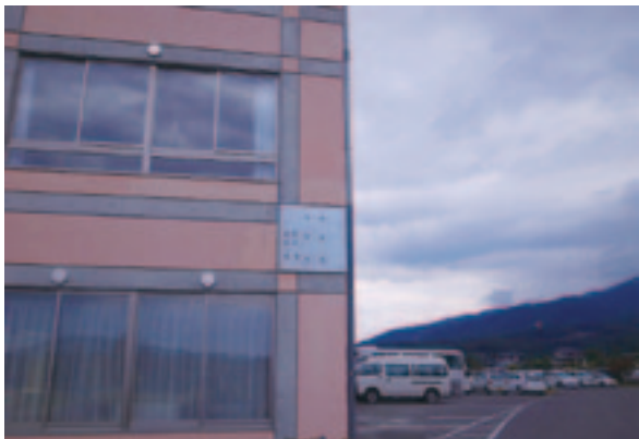
外壁補修部分
