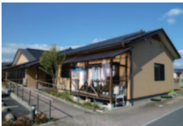
グループホーム外観 特に被害はない
