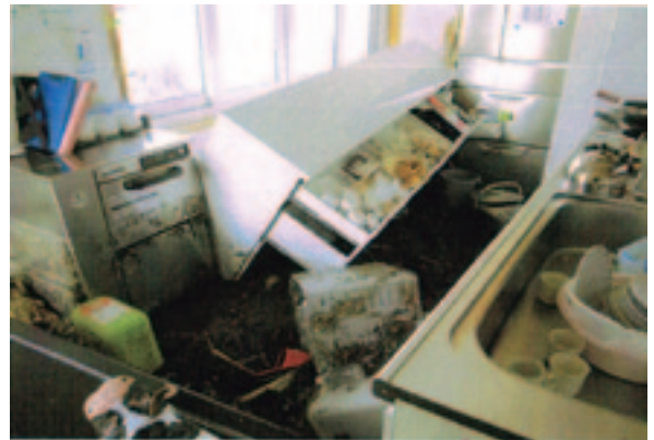
被災直後の状況 キッチン ※
