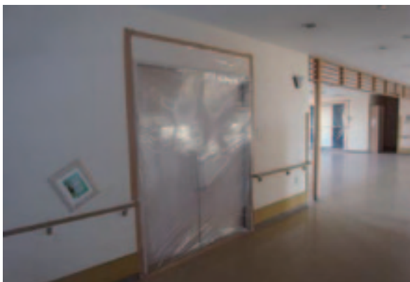
津波被害後清掃した交流スペース付近
