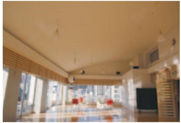
揺れが激しかった8階ホール
