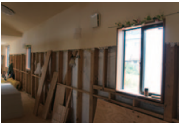
津波被害にあった施設（村伝）の改修状況
