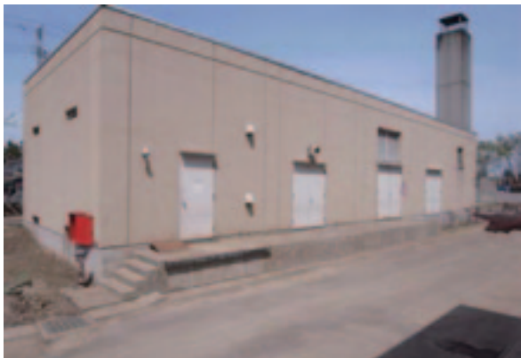
外部機械室（ボイラー、吸収式冷温水発生装置、ポンプ等） 地盤面より高い位置に設置
