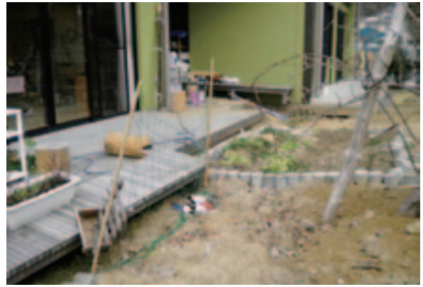
地盤沈下のため、中庭に大きな段差が発生 ※
