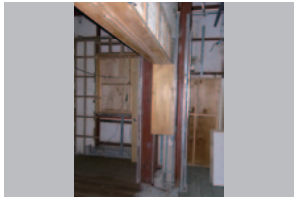
改修中の1階部分 内壁、断熱材を取り除き洗浄
