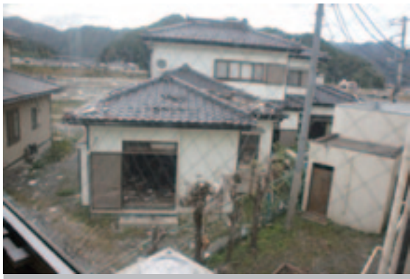
2階から敷地周辺を見る 屋根の上まで津波が到達
