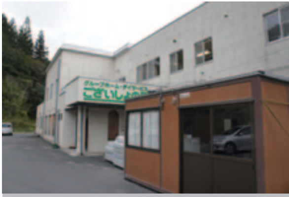
敷地外部のコンテナ 事務所スペースとして利用
