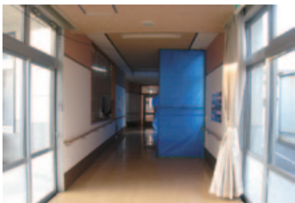
廊下 天井パネルの修理
