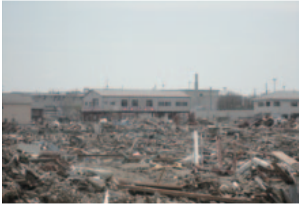
鉄骨造の当該施設以外は周辺はほとんど津波により流失されている状態
