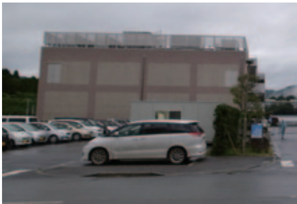
老健、病院のエネルギーセンター
