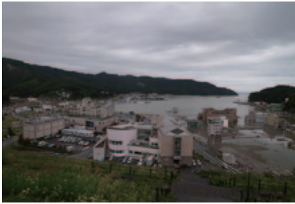
俯瞰 正面が老健、左に病院。奥の湾が女川港
