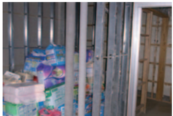
改修中の1階部分 支援物資を保管
