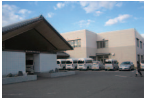
陸屋根部分は居室棟
