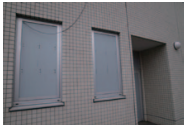
破損したガラスの応急措置としてケイカル板を嵌込
