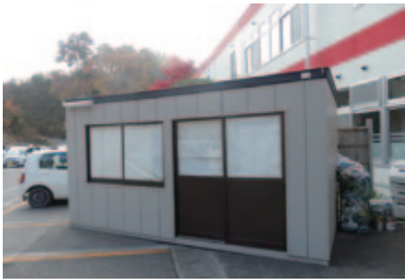
増設された防災備蓄庫
