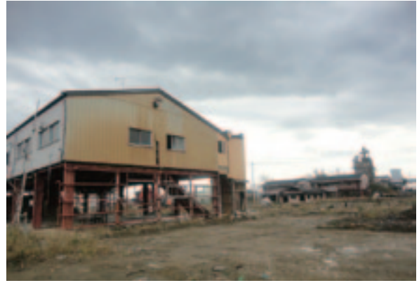
左がめだかの楽園（小規模多機能施設鉄骨造2階建て）、右手にめだかの楽校（デイサービス木造2階建て）が見える
