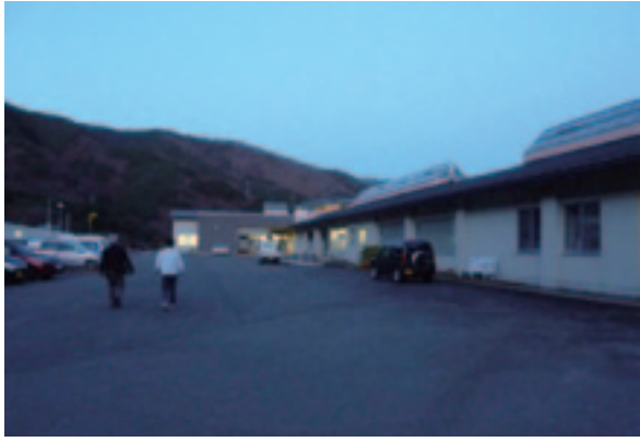
外観（北東向きにエントランスを見る）
