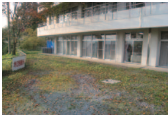
敷地内に第2 避難所として設けられていたスペース
