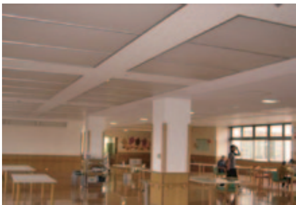
天井が落下した食堂・談話コーナー 復旧後
