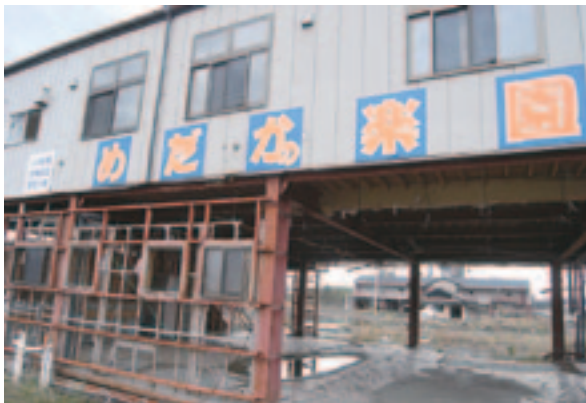
めだかの楽園の1階部分は壁が鉄骨のみ残されている状態
