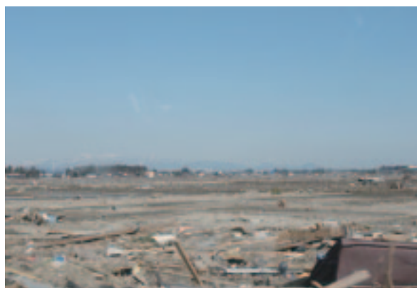
津波被害を受け壊滅的被害を受けた周辺
