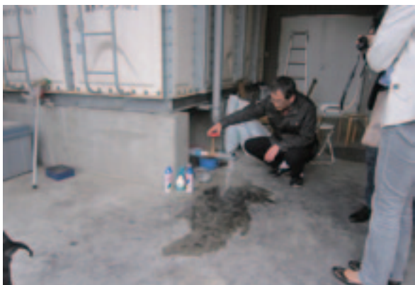
受水槽 直接取水
