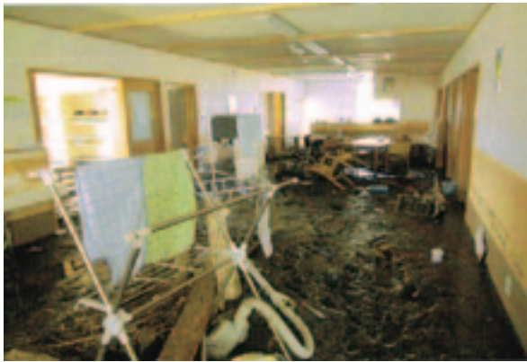
被災直後の状況 ホール ※
