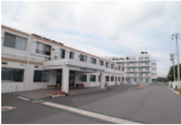
外観 特段の損傷無し 奥はケアハウス
