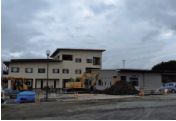
外観 躯体自体に大きな損傷なし
