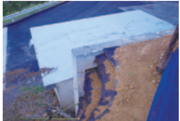
法面の崩壊 補修済み
