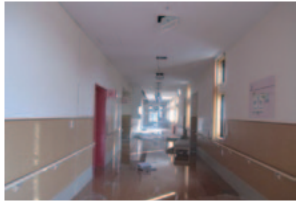
震災直後の状況 3階廊下 ※
