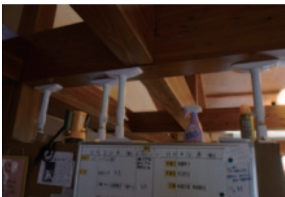
食堂 食器棚に取り付けた転倒防止用のポール
