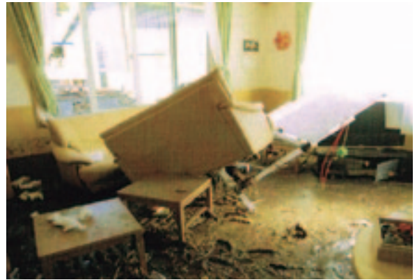
被災直後の状況 リラックスルーム ※
