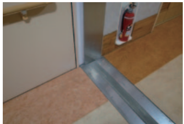
エキスパンション部分の補修
