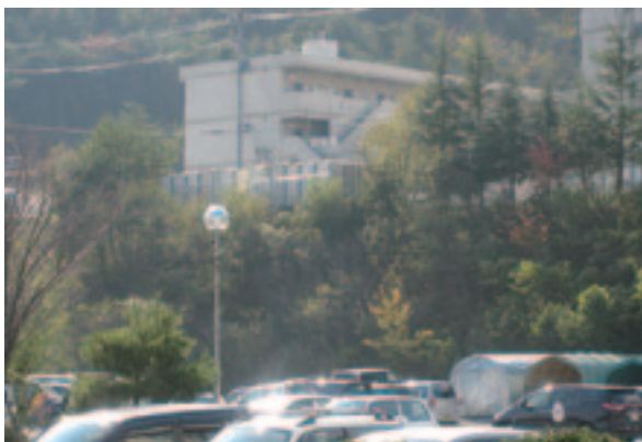
貯水槽 敷地内の施設に供給
