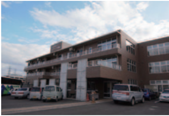
施設建物全景（震災後、補修後）
