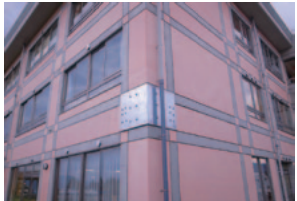
外壁補修部分
