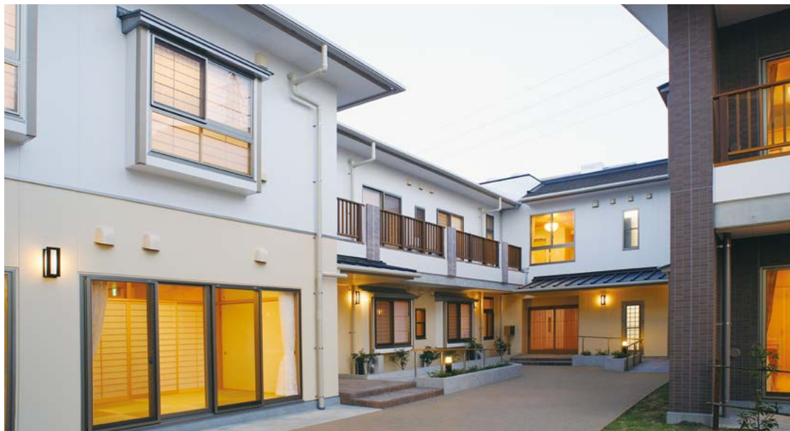
外観、中央奥が正面玄関*
