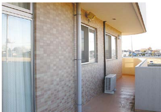
改修でつくられた居室には新たに窓を造作（中央）
