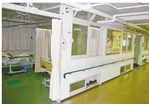
居室と廊下（西棟・改修前）＊
