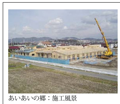
図表 4-6 木造準耐火（ツーバイフォー）の骨組み
