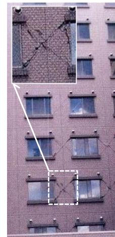
写真 1: ×印のひび(剪断破壊)
