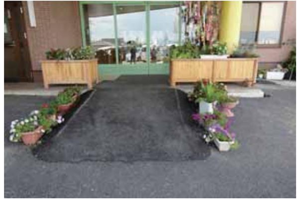
施設玄関（地盤沈下により一部補修）
