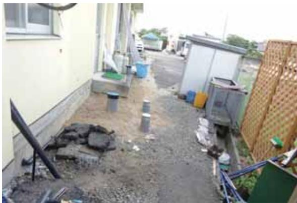
地盤沈下により傾く
