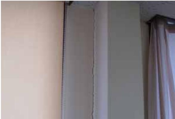
柱と壁の境界部分の亀裂
