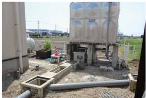
地盤沈下による受水槽付近の被害
